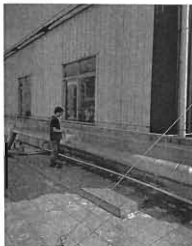
涂布、烘干工序废气进气口 1#
