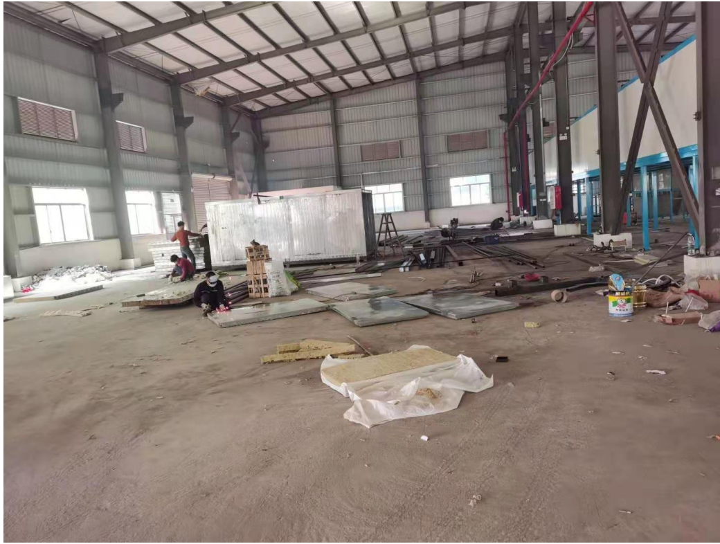
图五 厂区硬化地面
