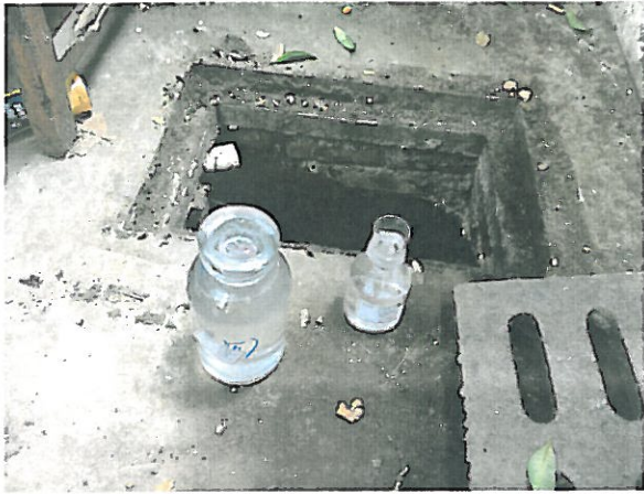
废水：生活污水排放口
